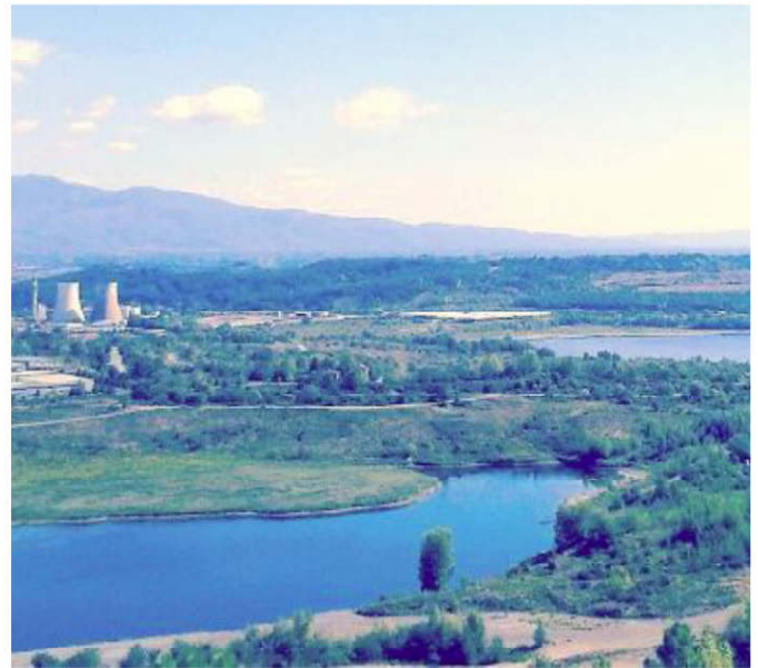
L'area dell'ex miniera di Santa Barbara fra Cavriglia e Incisa. Sullo sfondo la centrale termoelettrica dell'Enel
